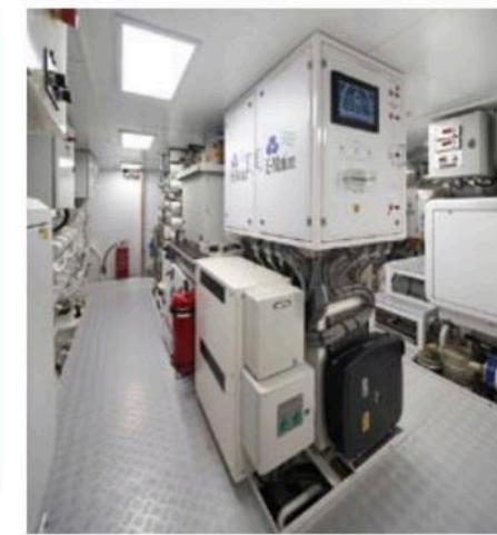
У Bintador четыре режима работы: традиционный на двух дизелях, дизель-электрический на двух электромоторах, гибридный на одном MTU и двух электромоторах и, наконец, буст-режим, когда работают все двигатели
